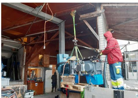
Die alten Motore werden in der Mittelstation Rietlig durch neue ersetzt.
