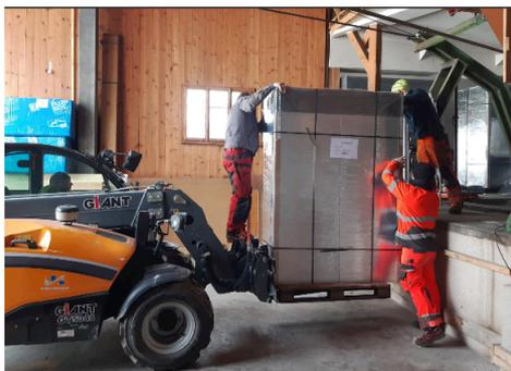
Einbau der neuen Steuerungsschränke in der Mittelstation Rietlig.
